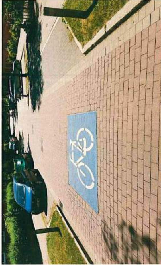
**Breite:** min. 4,00 m (min. 6,00 m mit Bus) RAST
